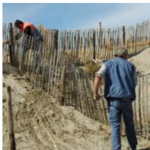
Pose de ganivelles
