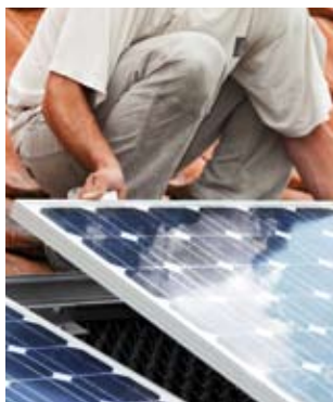
Pose de panneaux solaires
