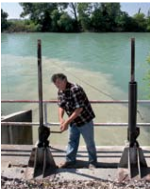
Ouverture de vannes
